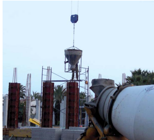
Procedimiento erróneo: Se han de utilizar castilletes.
